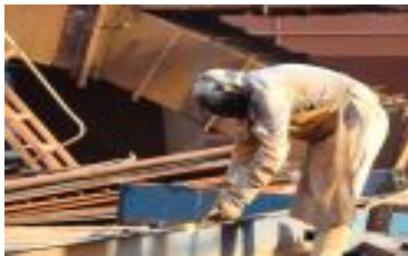
Figura 2: Funcionário realizando manutenção na MRN.
